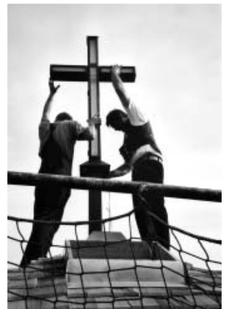
Offenbarungskirche: Dach und Kreuz sind bereits neu
