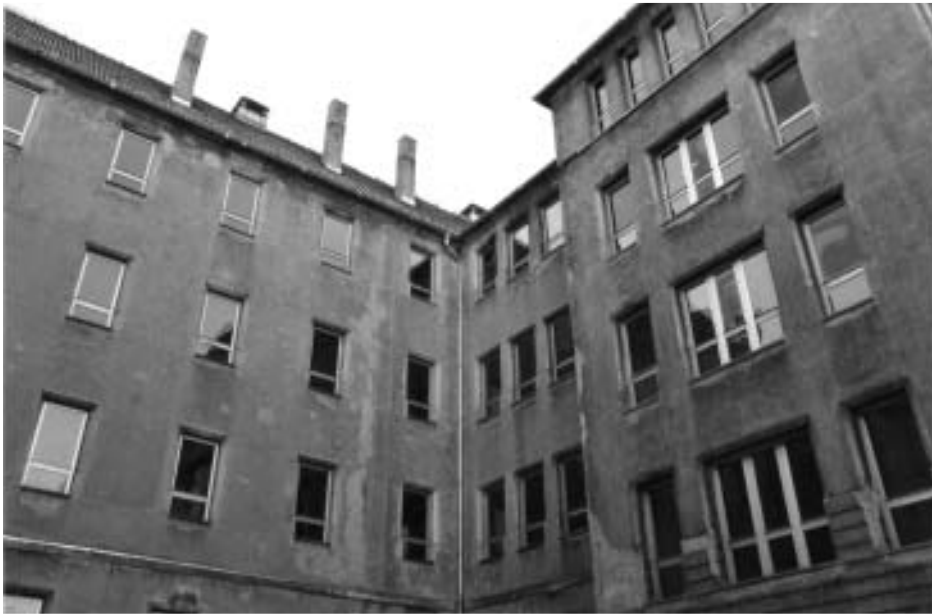
Konzepte für Nutzung der Schule in der Scharnweber Straße gesucht
