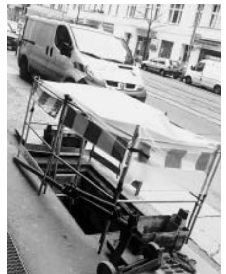
Damit es mit DSL bald klappt: Die Telekom vergräbt in Friedrichshain neue Kupferkabel
