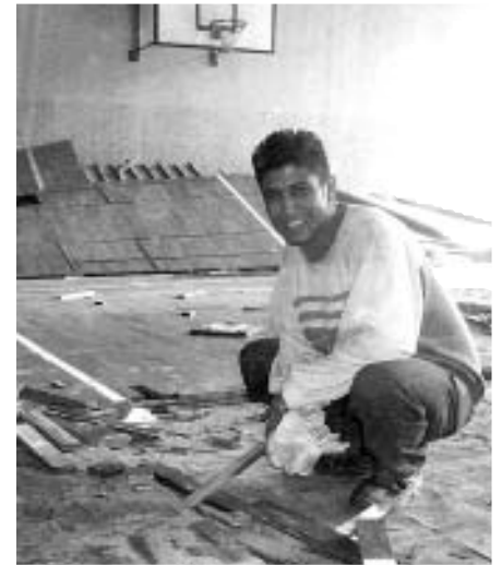
Hau ruck: Neuer Schwingboden für die Zille-Turnhalle
