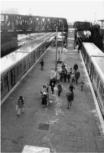
Umbau mit Umständen: Die Arbeiten am Bahnhof Ostkreuz beginnen in diesem Jahr
