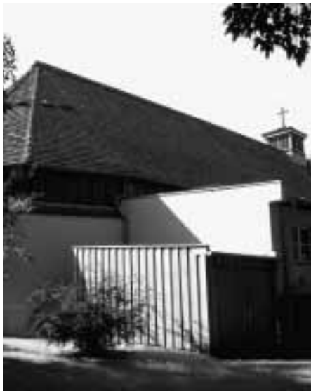
Umbau abgeschlossen, jetzt wird gefeiert: Offenbarungskirche in der Simplonstraße
